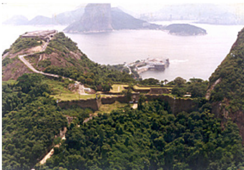
Figura 1. Complexo da fortaleza de Santa Cruz: em primeiro plano, o forte de São Luís, construído em 1777. Mais acima, o forte do Pico, de 1916. Ao fundo, a fortaleza de Santa Cruz. Do outro lado da baía, o Pão de Açúcar. Foto do autor.
