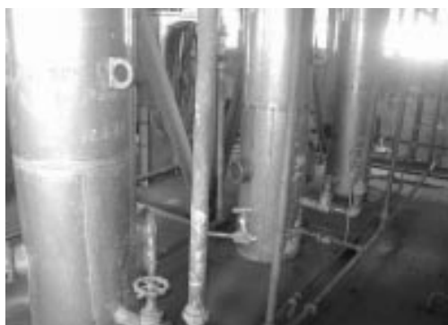
Fig. 3. Tratamientos de desinfección. Torres de ozonización.
