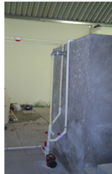
Figura 6. Bomba y circuito de recirculación de agua.
