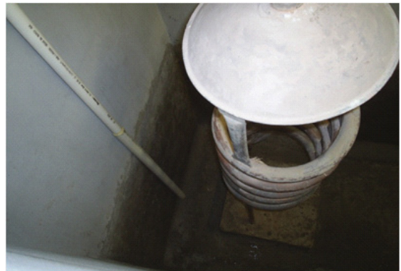
Figura 5. Serpentín de condensación.
