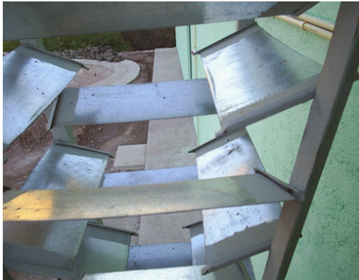
Figura 3. Empaques o paletas de la torre de enfriamiento.
