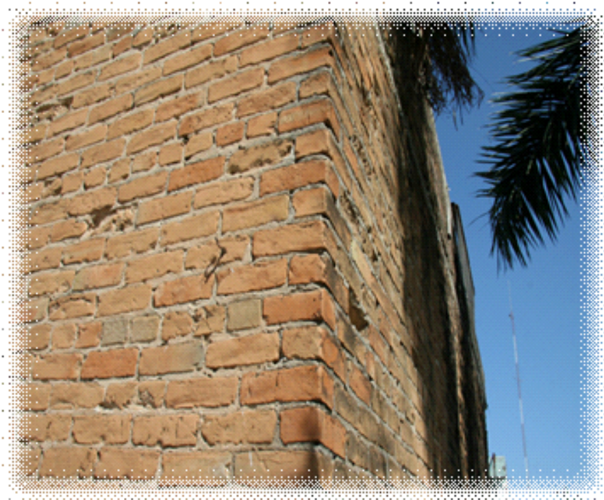
Figura N° 4. Desplante de muro de ladrillo de milpa de vivienda tradicional Con cuatrapeo en las esquinas
