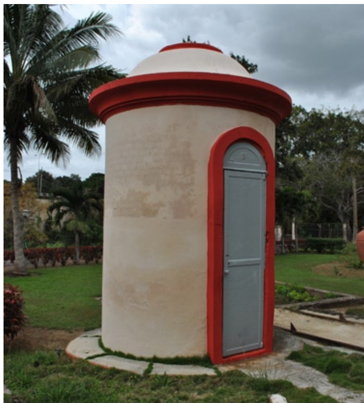
Torre de ventilación del Canal de Albear.
