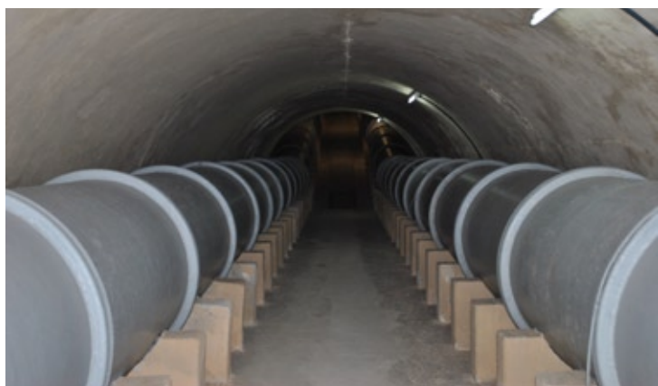
Túnel sifón bajo el río Almendares.
