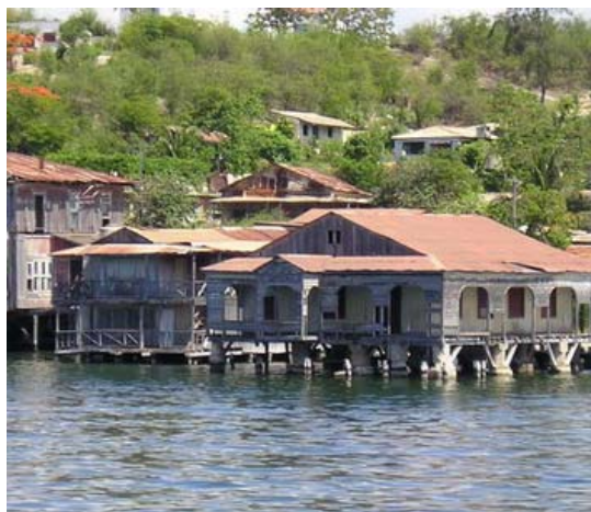
Conjunto de casas de madera en Cayo Granma, donde se aprecian los pilotes.
