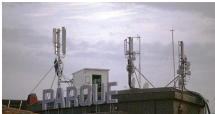
Figura 4. Estaciones base de telefonía sobre el tejado de un edificio. En los dos mástiles de la derecha pueden observarse radioenlaces. El operario encaramado en el mástil de la izquierda está montando el nuevo sistema UMTS. (Fuente: Alfonso Balmori)
