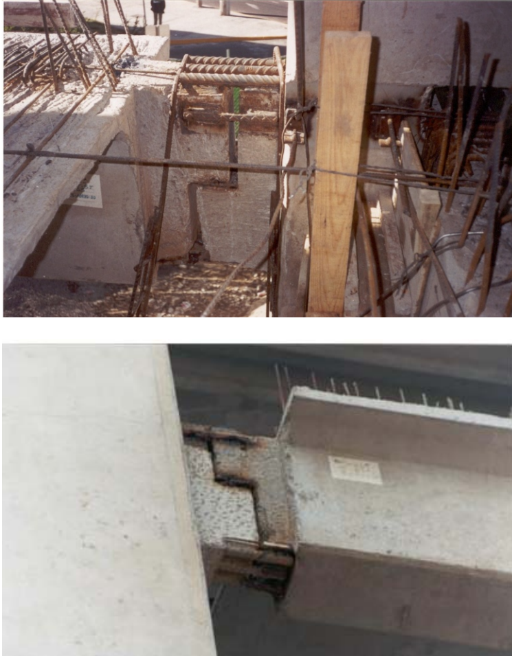
Figura 1. Ejemplos típicos de conexiones trabe-columna de concreto prefabricado en un edificio de 15 niveles en el Distrito Federal.
