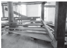
Figura 8 - Exemplo da passagem do pré-artezanato ao industrial design : Solar do Unhão, recuperação do edifício, com a construção da nova escada (foto: W. Nick). Fonte: Inst. Lina Bo e PM Bardi.
