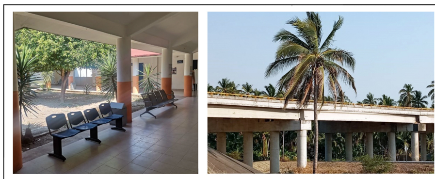
FIGURA 1 Uso de columnas circulares de concreto reforzado
