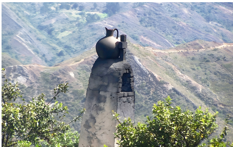
Figura 2. Copa de la chimenea del horno
