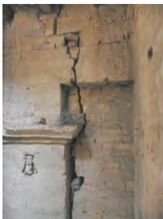
➤ Figura 16. Torre de la iglesia. Se observan las grietas en su interior.
