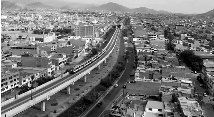
Figura 3 – Vista del recorrido de la Línea 1 del Metro de Lima desde Estación inicial/final Bayóvar, San Juan de Lurigancho
