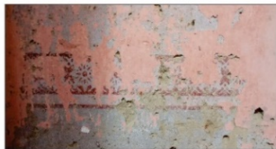
Desprendimientos pintura interior
