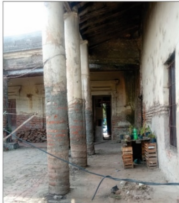
Columnas cubierta con cemento
