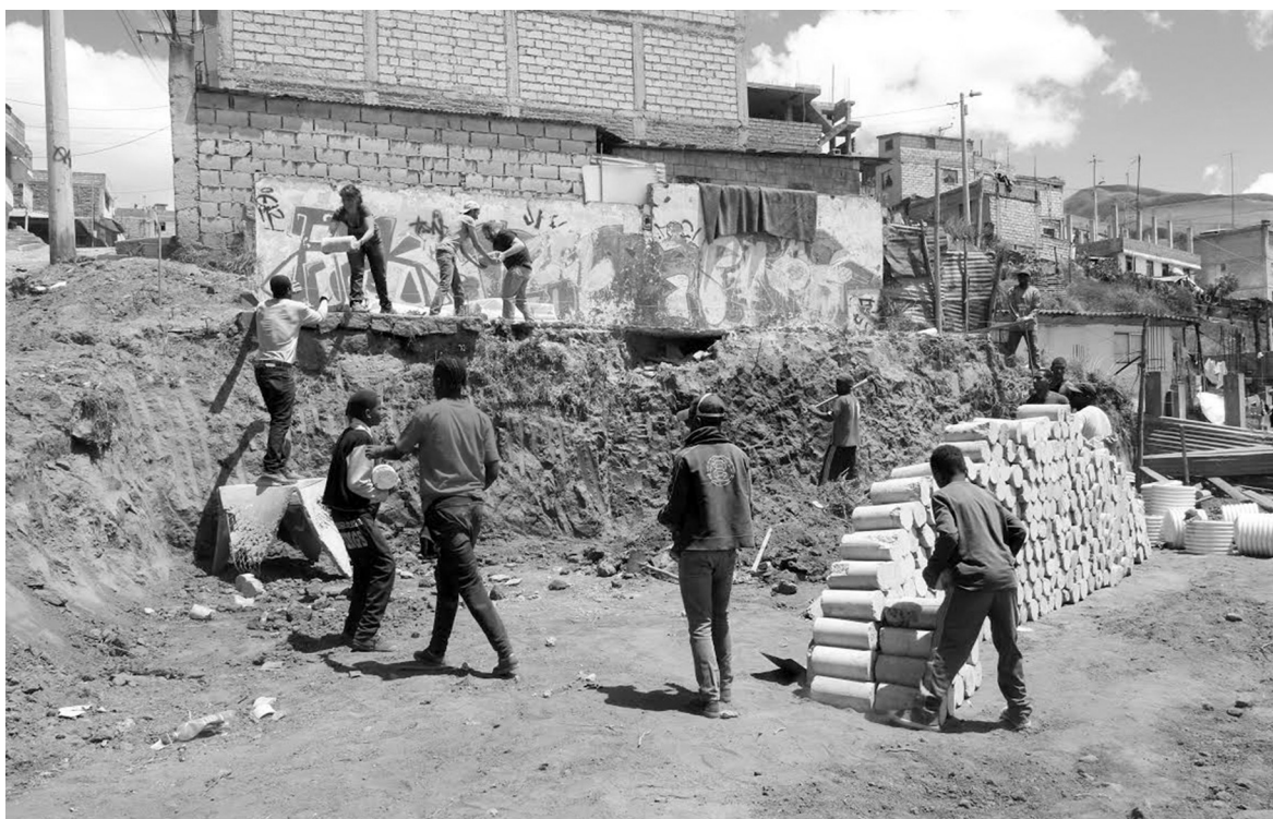
MATERIAL POLITICS ► Trabajo colectivo de construcción para recuperar la plaza entre jóvenes de la organización Cofradía, Al Borde Arquitectos y Material Politics. Atucucho, Quito, 2015.
