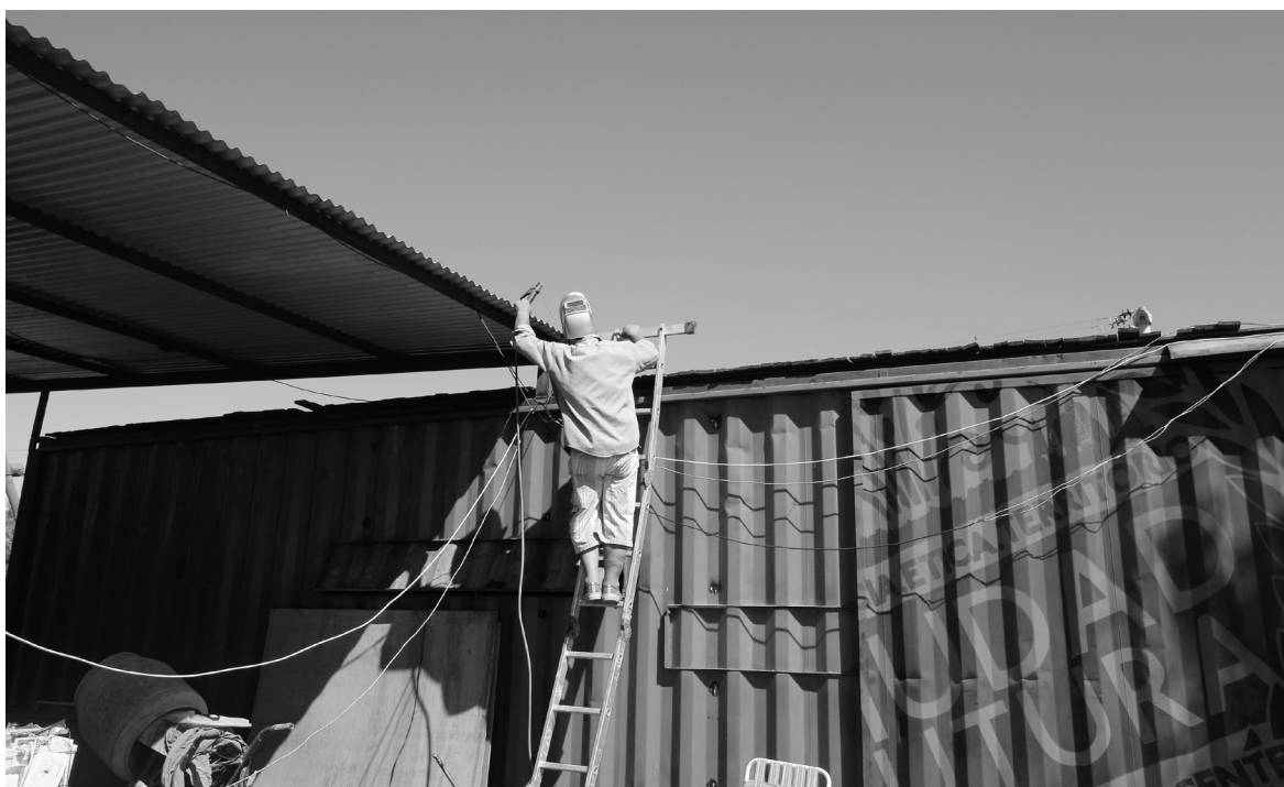
MATERIAL POLITICS ► Trabajo de recuperación de contenedores para construir un espacio educativo en Nuevo Alberdi, Rosario, Argentina. Intervención de Material Politics y Ciudad Futura, 2016.
