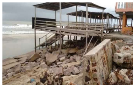
Figura 4: Vista inferior después de la erosión
