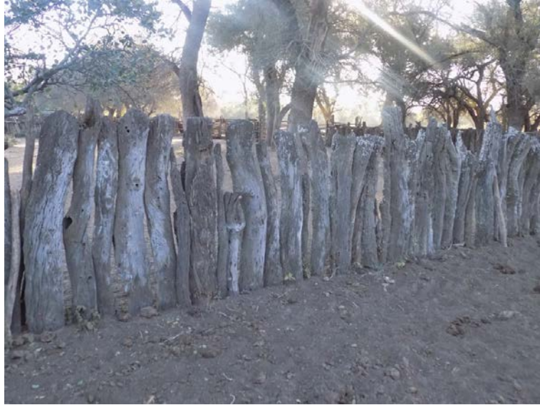
Imagen núm. 10: Estructura usada en los potreros para contener el paso de los animales. Consiste en troncos de quebracho colorado enterrados uno al lado de otro.
