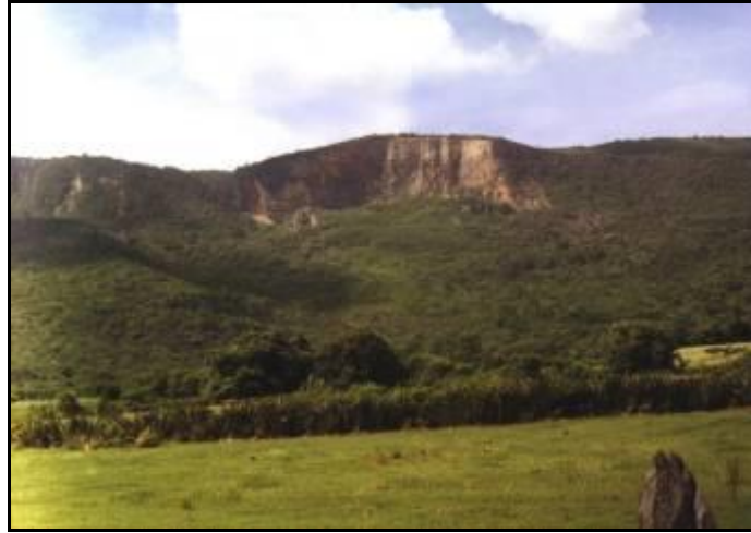
Figura 2. Vista del deslizamiento Los Jagüeyes en el escarpe de la Sierra de Caujerí (Castellanos, 2000)
