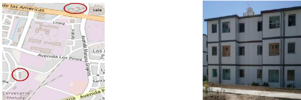
Figura 1. Ubicación y ejecución de edificios con proyecto español en las urbanizaciones Las Américas zona-6 y Jardines de la Cervecera
