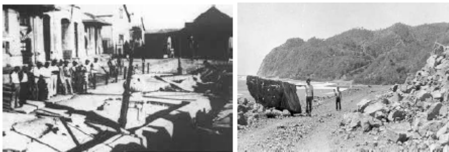
a) Daños producidos en la zona de La Alameda b) Deslizamiento que compromete la red vial
