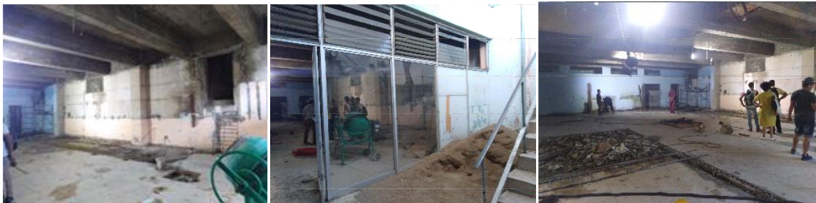
Interior del espacio de la antigua cafetería de la UO, en proceso de rehabilitación
