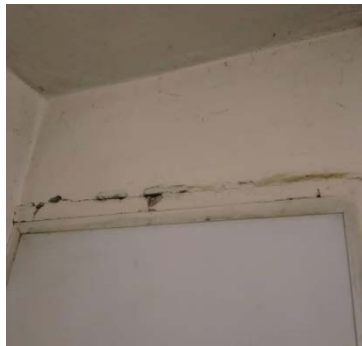
e) Grietas longitudinales en vigas por corrosión
