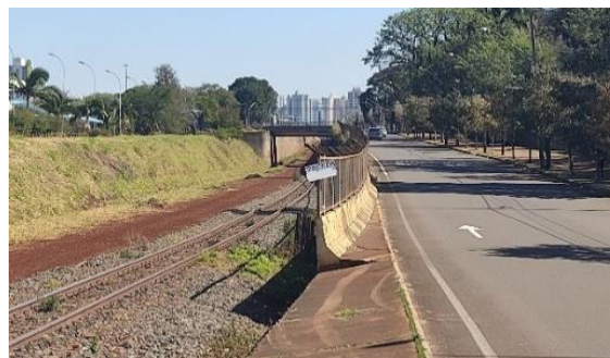
Figura 2 – Infraestrutura ferroviária em Maringá/PR. Fonte: Autores (2021).
