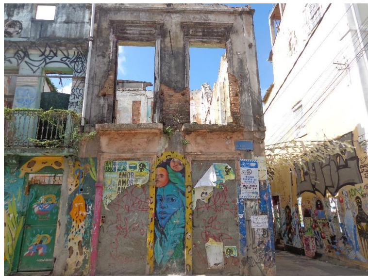
Figura 10 – Sobrado 101, Santo Antônio. Fonte: Autoria própria (2022).
