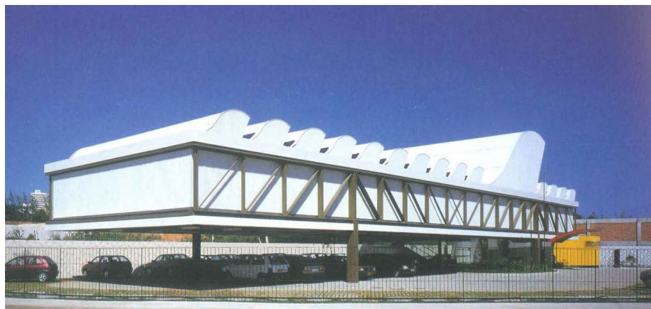
Figure 32: Sede do Tribunal de Contas da União no Estado da Bahia . (Source: Carvalho & Latorraca, 2000, p. 218)
