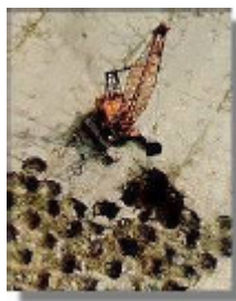
Fig.5: Compactación dinámica por caída de peso [5].
