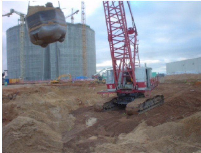
Fig 6: Compactación dinámica por caída de peso. [5]
