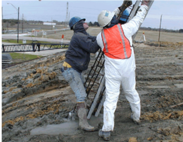
Fig 3: Colocación de refuerzo en pilote tipo CFA [6].
