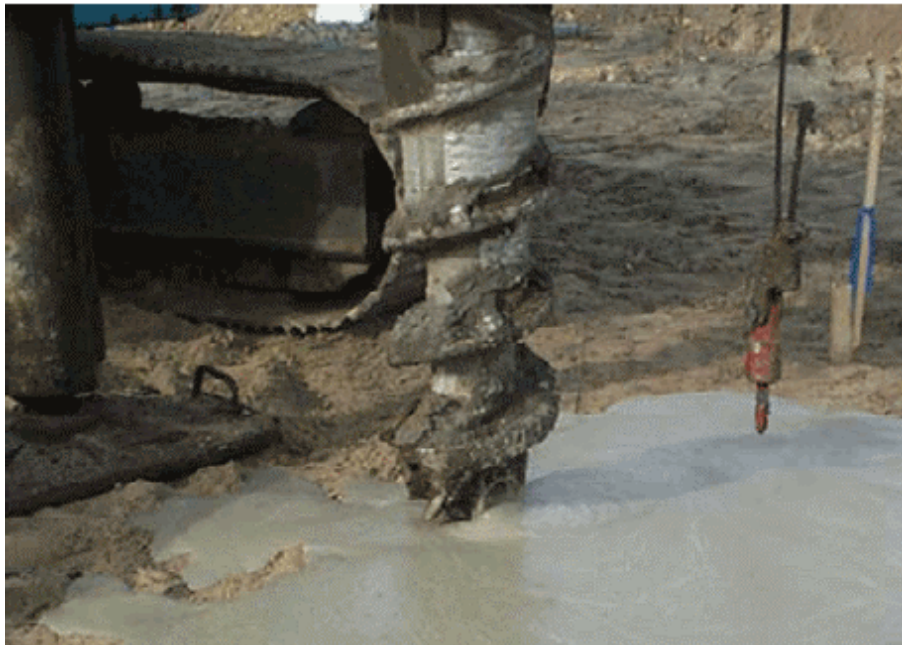
Fig.2: Excavación pilote tipo CFA [6].
