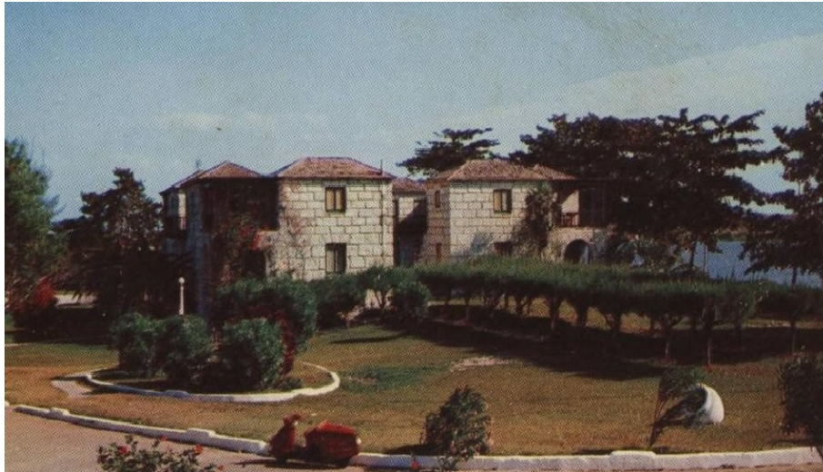
Figura 3 Instalación El Cortijo.
