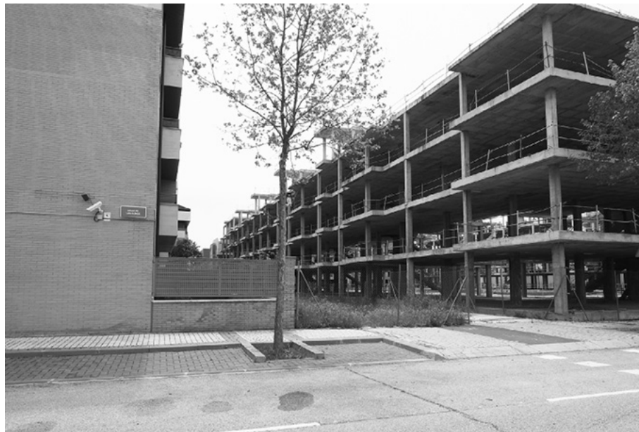
FIGURA 3 Viviendas inacabadas en Ciudad Valdeluz (Guadalajara) FOTOGRAFÍA DE LAS AUTORAS (2016)
