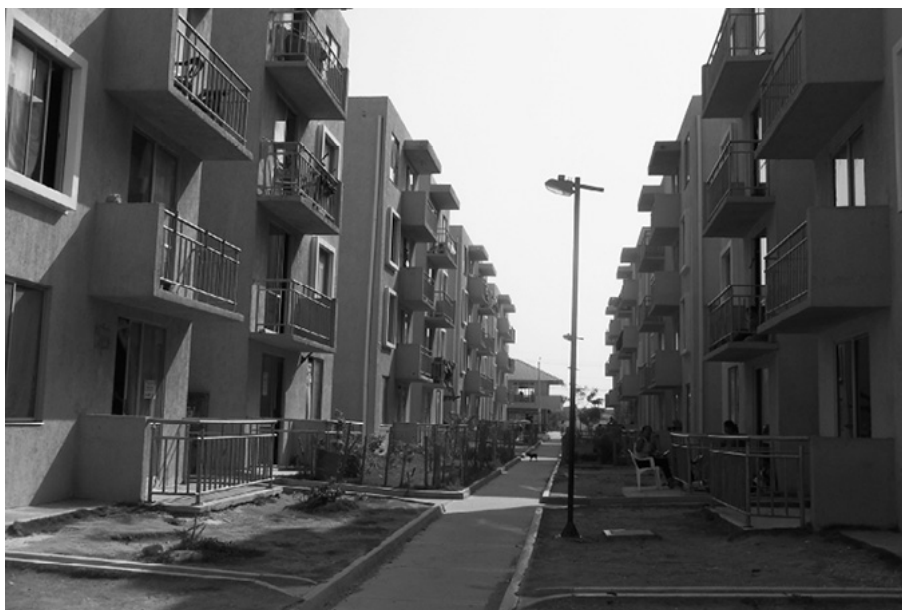
FIGURA 7 Espacios comunales Villas de San Pablo, Barranquilla FOTOGRAFÍA AUTORES
