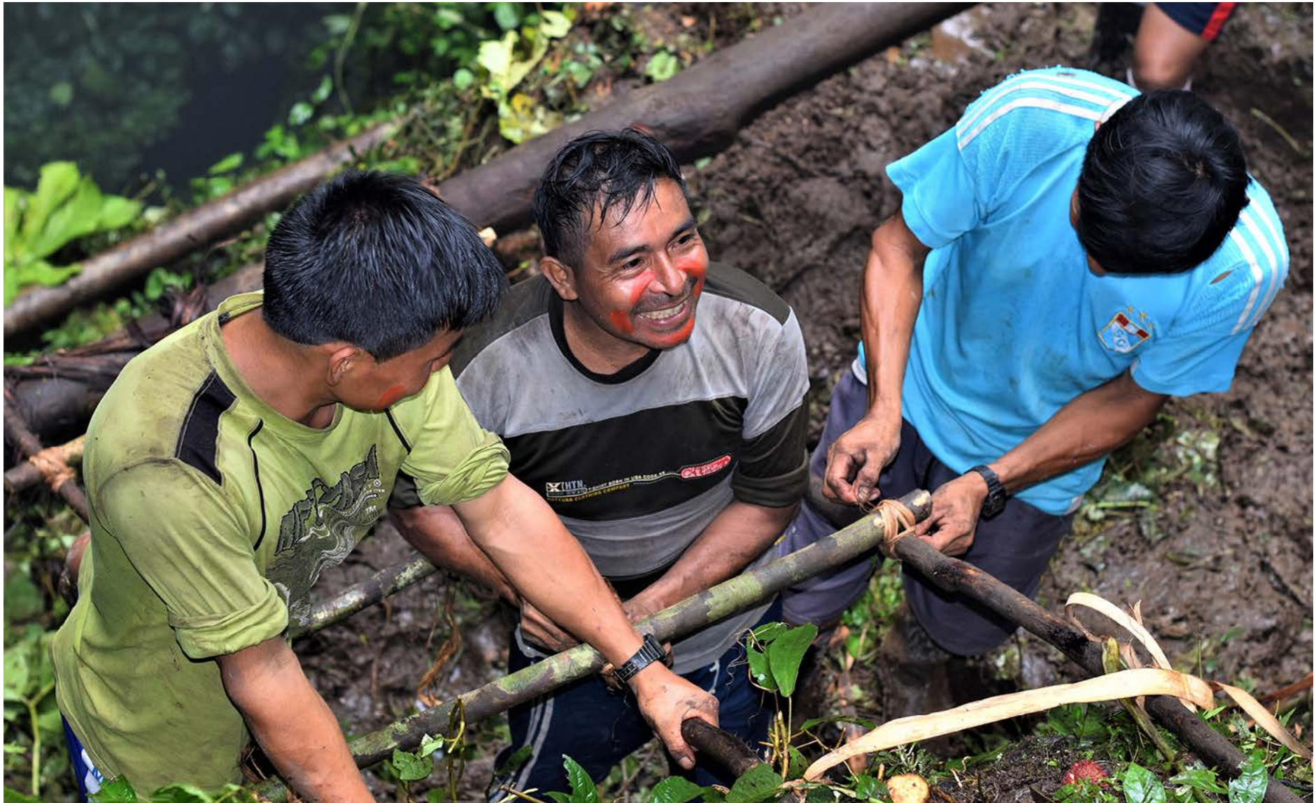
Viernes, papaja yaki watai najambau (construcción de la escalera)
