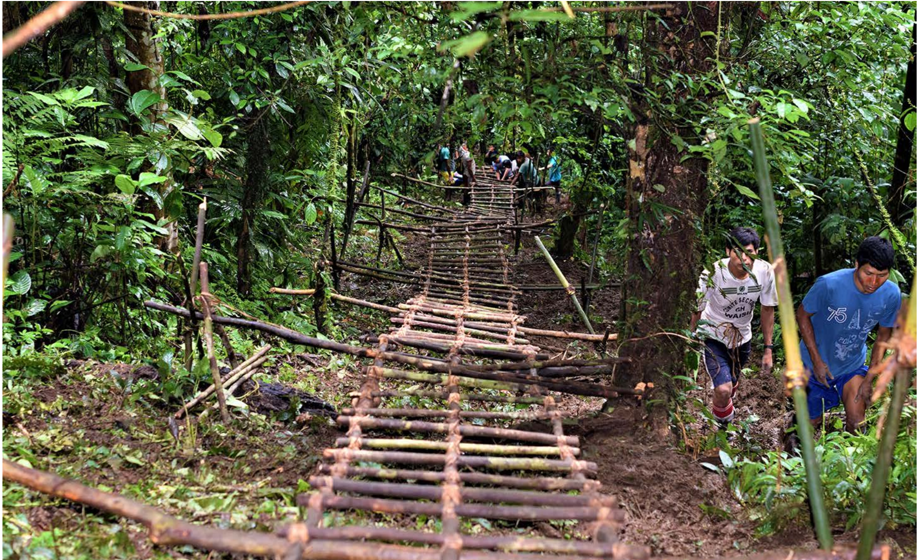
Sábado, papaja yaki watai najambau (construcción de la escalera)
