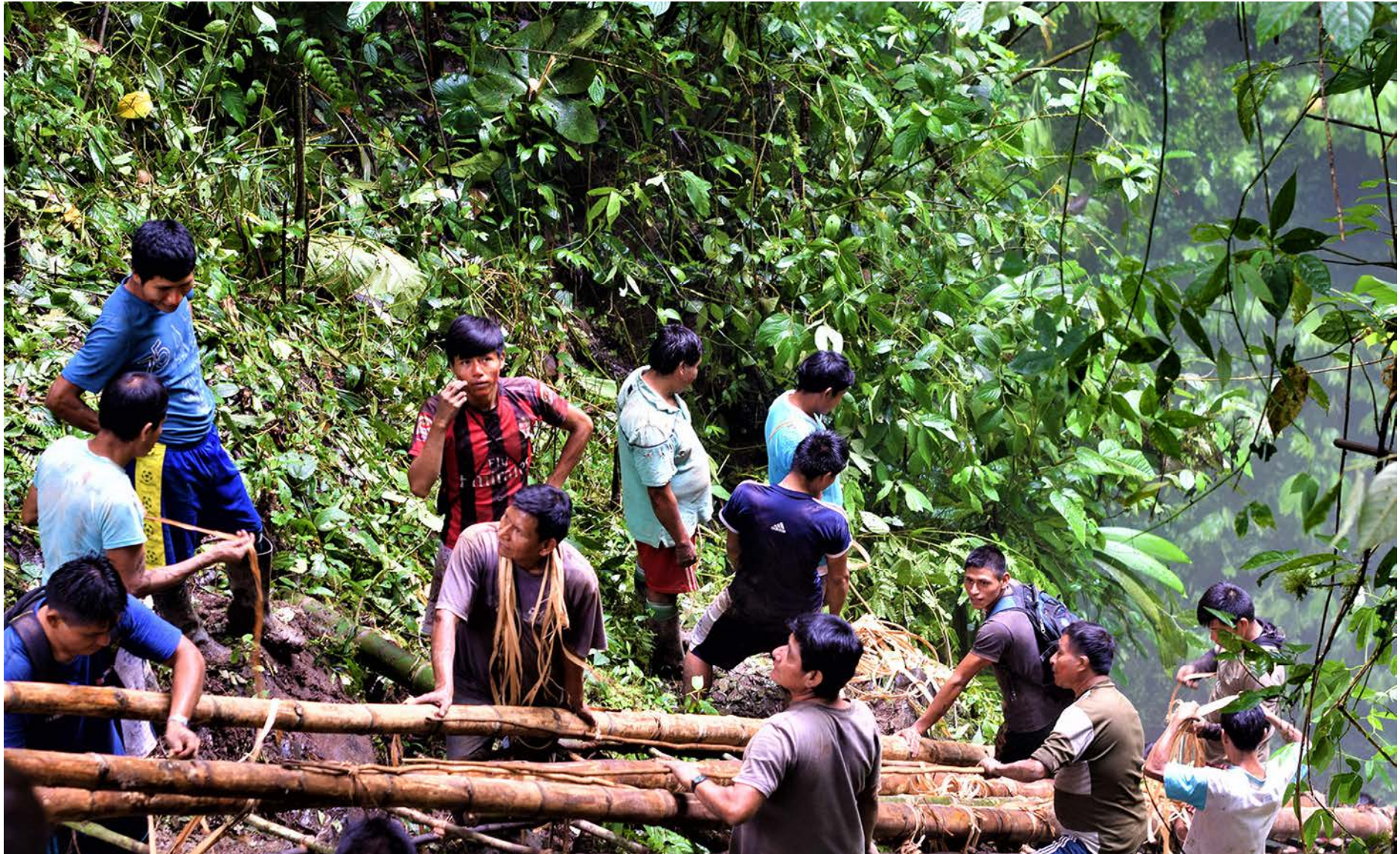
Domingo, introducción de la escalera
