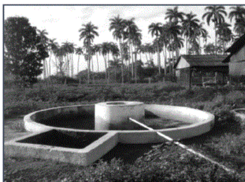
Foto 1. Biodigestor de 45 m 3 .
