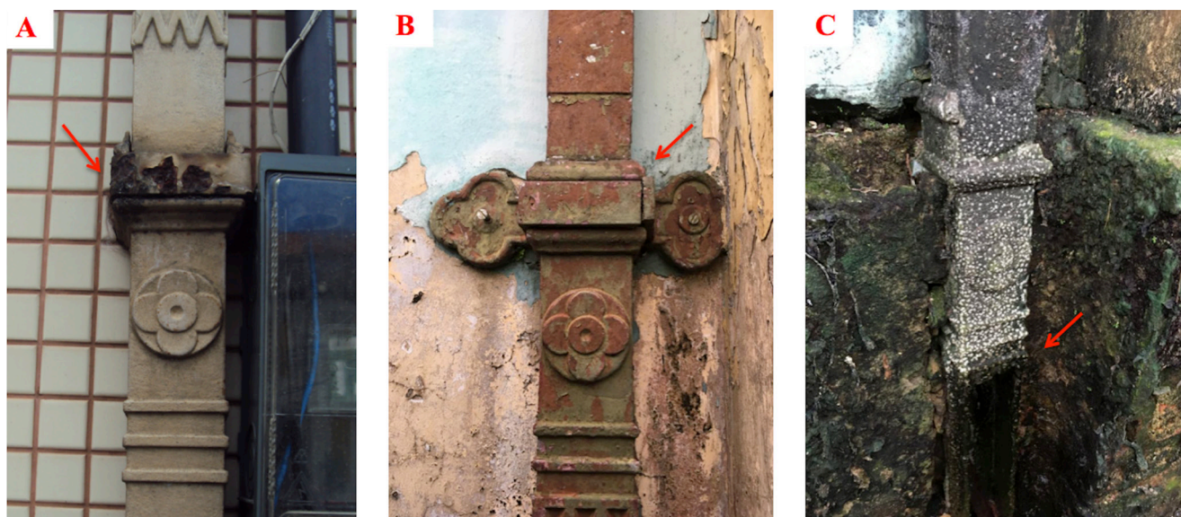
Figura 6 – Dutos apresentando: (A) destacamento da camada de tinta e produtos de corrosão na superfície; (B) corrosão superficial generalizada e destacamento de parafusos; (C) corrosão generalizada e manchas de umidade na base do corpo. Fonte: Fotografias das autoras.
