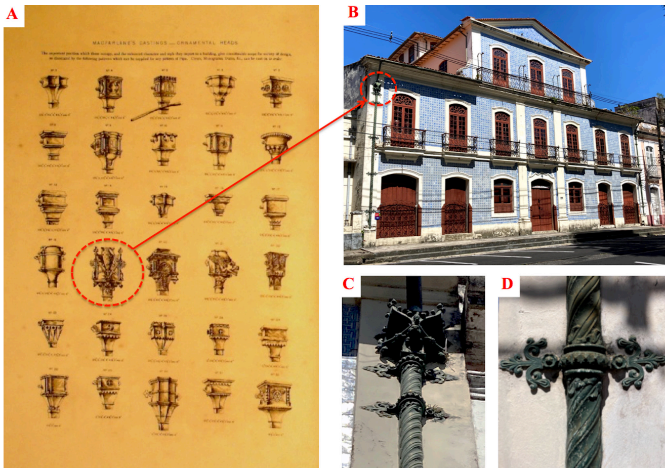
Figura 1 – (A) Imagem do catálogo da W. MacFarlane & Co. com indicação do modelo de cabeça utilizado no Solar Barão do Guajará em vermelho (B) e imagens aproximadas da cabeça, corpo e braçadeiras do duto vertical na fachada do edifício. Figura (A) retirada do Catálogo W. MacFarlane & Co.; (B, C, D). Fonte: Fotografia das autoras.
