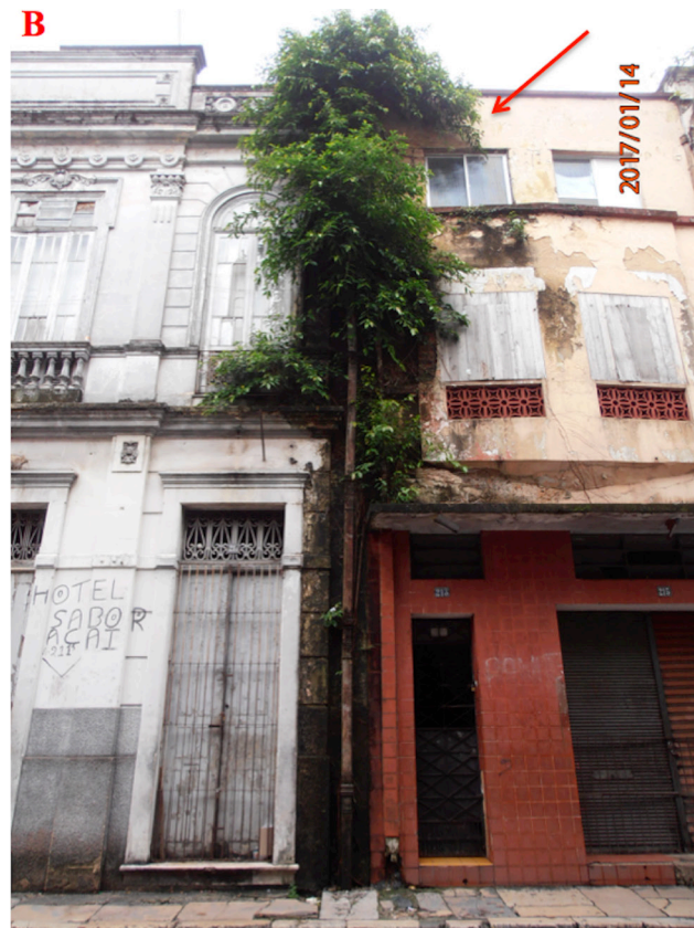
Figura 9 – (A) Placa de propaganda que impede a leitura da fachada e demais elementos integrados. (B) Vegetação de grande porte em fachada no bairro da Campina. Fonte: Fotografias das autoras.
