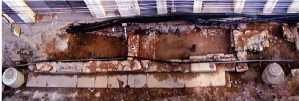
Figura 9 – O cais exposto pelas escavações: 1) cantaria de atracação; 2) estrutura de apoio; 3) murtas transversais; 4) fundações dos edifícios do trapiche, parcialmente expostas. Foto: Studio Soma.
