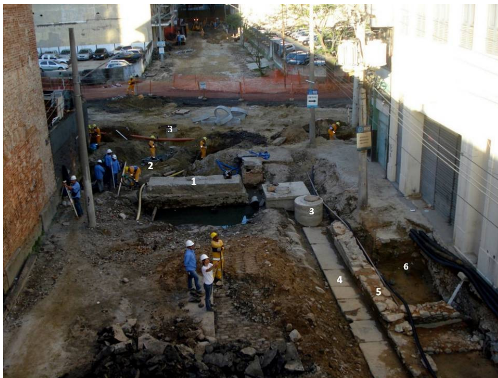
Figura 23 – Rua Coelho e Castro, escavações arqueológicas em andamento. Vista do ângulo oposto ao da foto anterior. (1) O primeiro píer encontrado; (2) o segundo píer, oblíquo, ainda em processo de escavação; (3) poços de visita recentes; (4) cais de atracação; (5) estrutura de apoio; (6) esteios remanescentes de tabuados. Fonte: Studio Soma.
