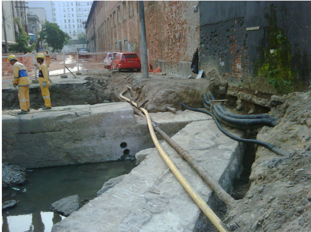
Figura 8 – O píer 2, oblíquo em relação ao cais e mais recente do que o píer 1, que se encontra logo atrás. À direita, o monumental Edifício das Docas D. Pedro II, que bloqueou o acesso dos trapiches ao mar. Foto: Andrea Jundi.
