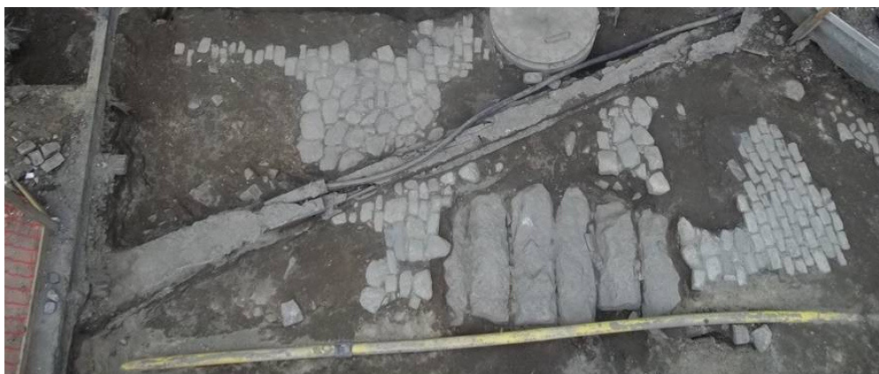
Figura 34 – Os diferentes calçamentos do Beco da Pedra do Sal: a sequência inferior de longas pedras retangulares, mais antiga; o trecho de paralelos, à direita; e, à esquerda, o que foi designado como piso misto, com paralelos e pedras arredondadas. Foto: Andrea Jundi.
