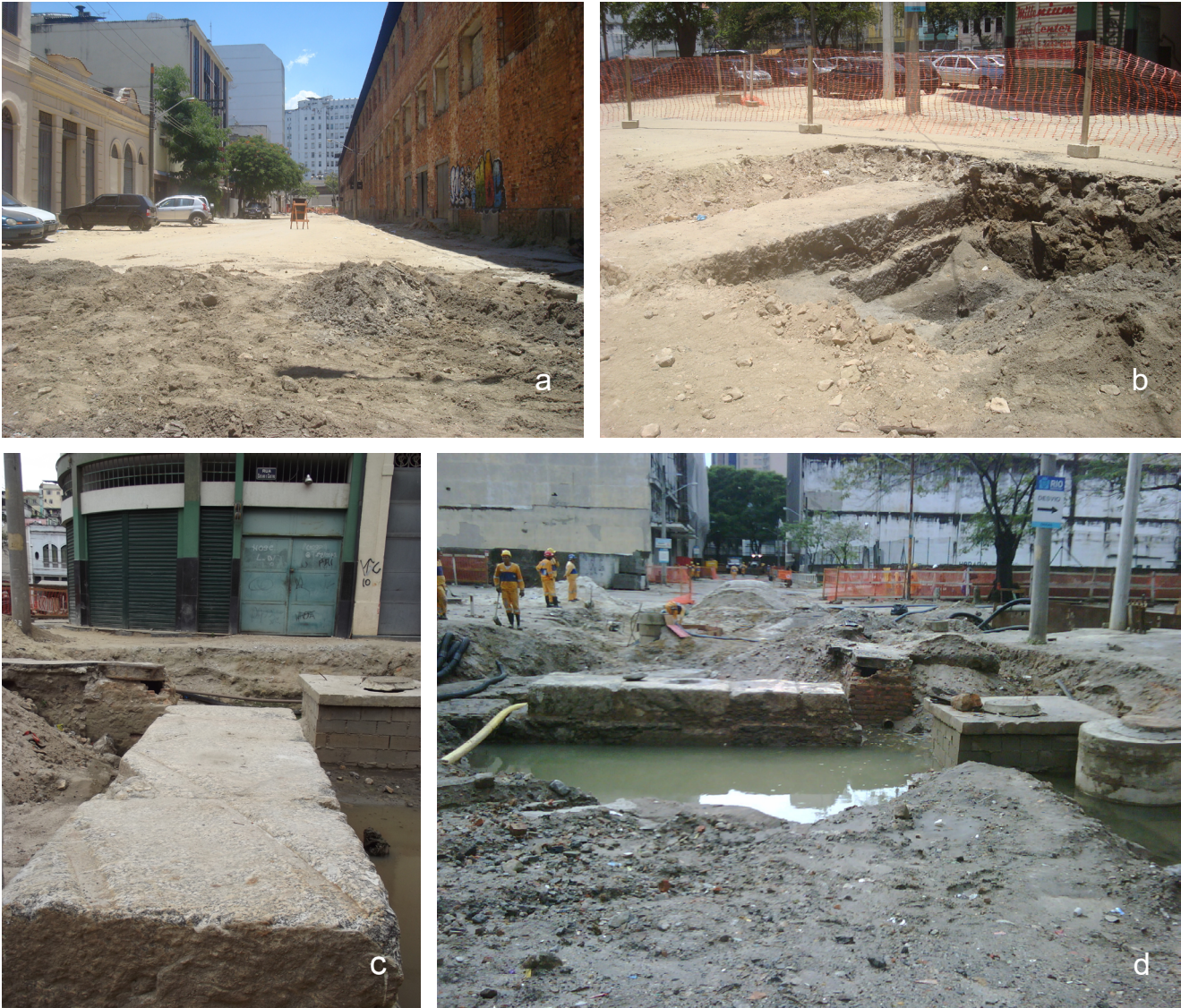
Figura 6 – Sequência da exposição progressiva do píer de alvenaria de pedra na Rua Coelho e Castro: (a) a rua antes do começo dos trabalhos; (b) início da escavação progressiva da estrutura; (c) o píer, visto da sua extremidade anterior; (d) o píer exposto, parcialmente imerso no lençol freático, destruído nas suas extremidades por obras anteriores. Fotos: Andrea Jundi.
