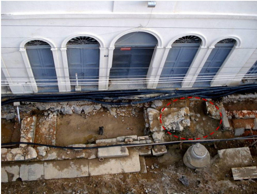
Figura 15 – A área de transição entre os trapiches, com bloco retangular de alvenaria robusta, uma possível base de apoio para o equipamento destinado a içar cargas. Foto: Studio Soma.
