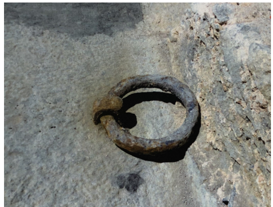
Figura 10 – Detalhes da cantaria de atracação: (a) e (b) rebaixo no bloco central (perfil e frente) com remanescentes de ferragens e recortes; (c) quatro degraus laterais de acesso ao cais de atracação; (d) e (e) argolões de metal para amarração encontrados na cantaria do cais, a 11 m de distância um do outro. Fotos: Andrea Jundi.
