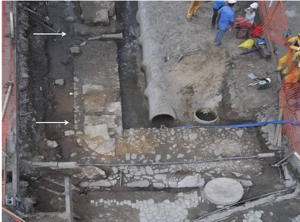
Figura 39 – Delimitação do vão de 4,0 m de extensão para entrada de cargas de grandes dimensões. Foto: Andrea Jundi.
