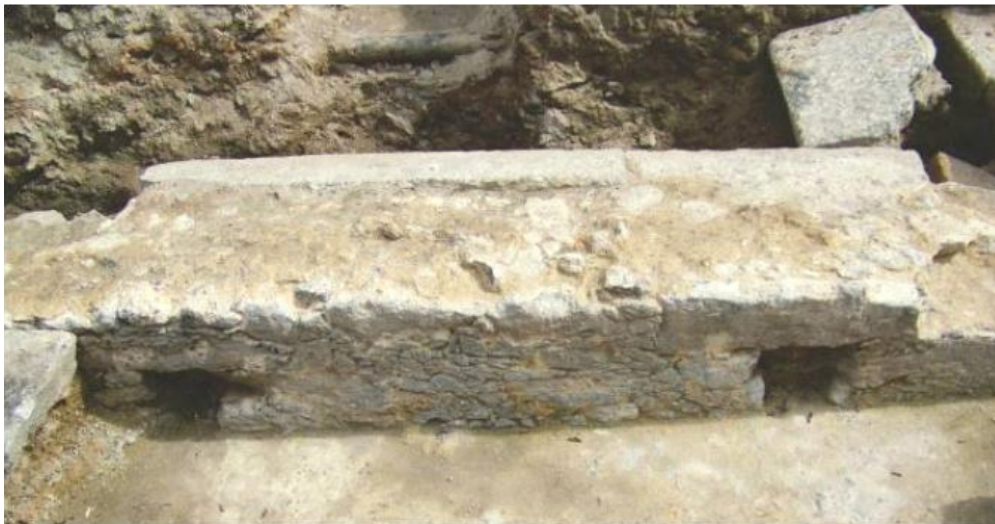
Figura 31 – Nicho para engaste de peça para elevação de cargas até a altura da soleira da porta. Foto: Andrea Jundi.
