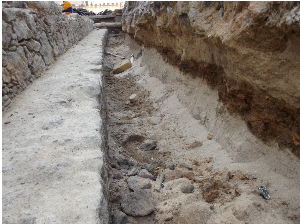
Figura 25 – Comprovadamente, o Trapiche da Pedra do Sal foi construído sobre a areia branca da antiga Prainha, como mostra o respaldo (ambos no mesmo nível). Foto: Andrea Jundi.
