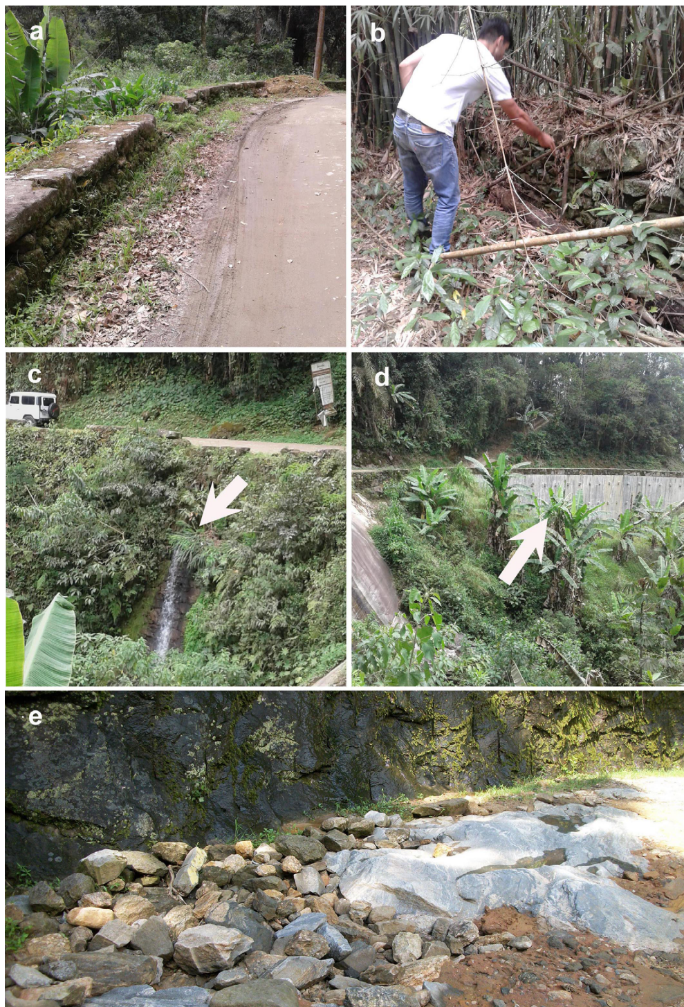
Figura 5- Estrada de Mangaratiba: Mureta de contenção em alvenaria de pedra seca (a); mureta de contenção em trecho abandonado (b); muros de contenção frontais à Cachoeira dos Escravos (c,d); blocos deslizados na Cachoeira dos Escravos em 2008 (e). Fotos: Soraya Almeida, 2018.
