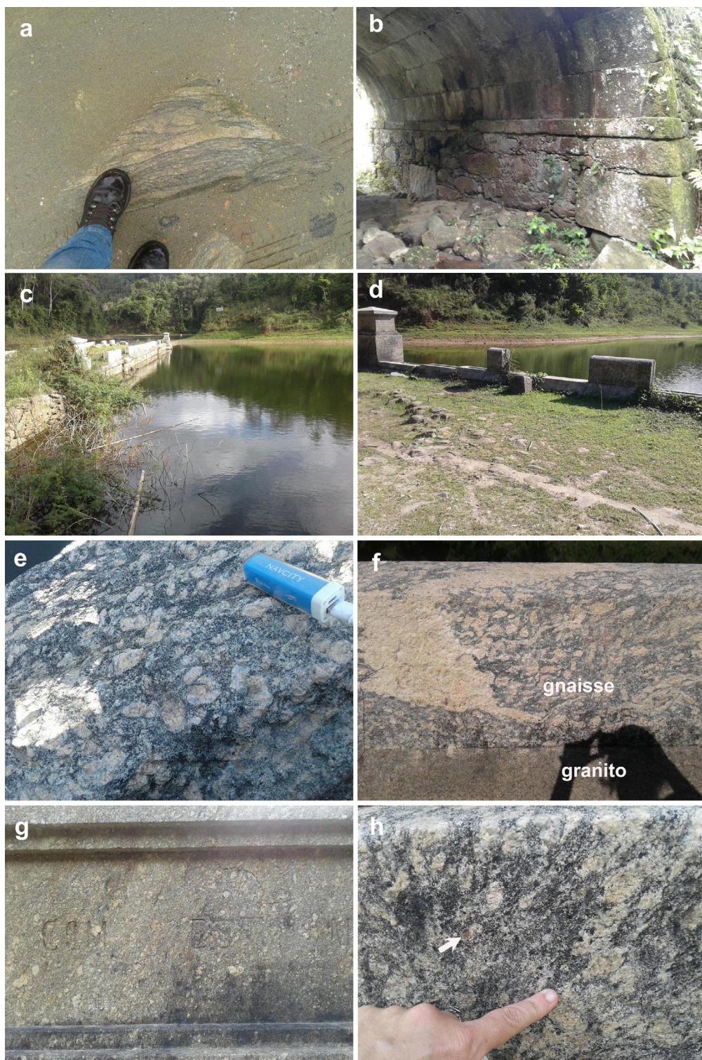
Figura 8 – Gnaiss migmatítico (a); Granito Mangaratiba, ponte próxima ao Pouso Triste (b). Elementos da Ponte Bela (c), blocos do tabuleiro (d), granito porfírico (e), gnaiss porfiroclástico (f), Granito Mangaratiba (g), gnaiss porfiroclástico com granada (h). Fotos: Soraya Almeida, 2017.
