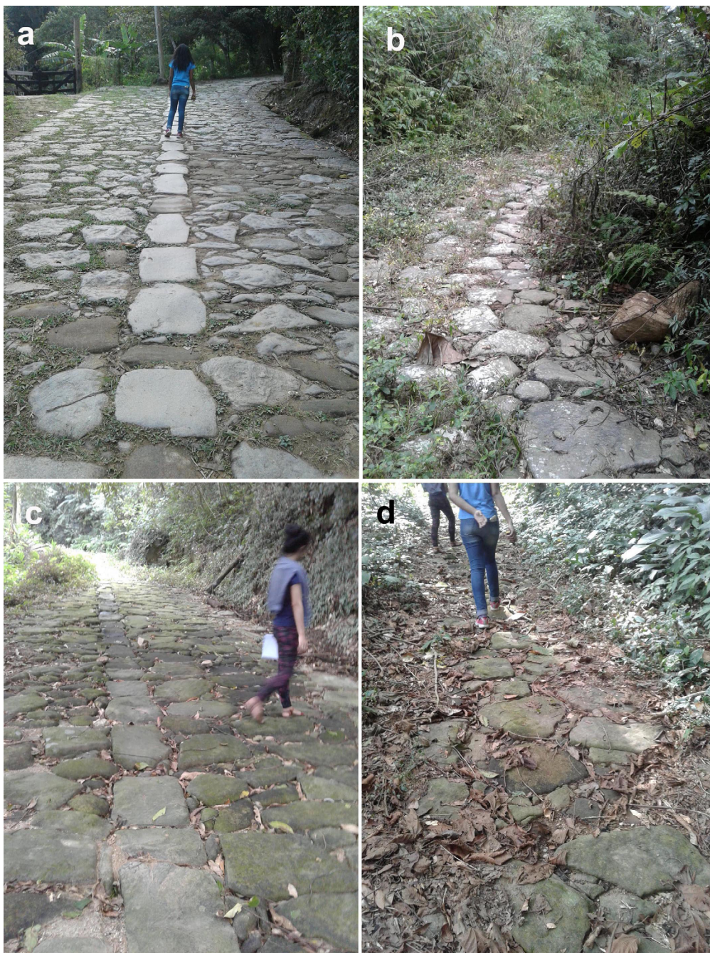
Figura 4 – Estrada do Atalho no trecho de subida da serra. Segmento com margines e capistrana (a,c); segmento com blocos rústicos e sem capistrana (b); trecho na cota de 170 m (d). Fotos: Soraya Almeida, 2018.
