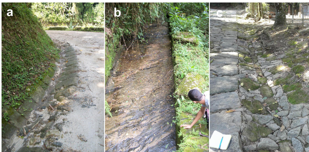
Figura 6 – Calha interna na encosta da Estrada de Mangaratiba. Ao fundo, mureta de contenção adjacente a uma calha externa (a); calha esculpida em rocha na encosta da Cachoeira dos Escravos (b); calha unilateral na Estrada do Atalho (c). Fotos: Soraya Almeida, 2018.
