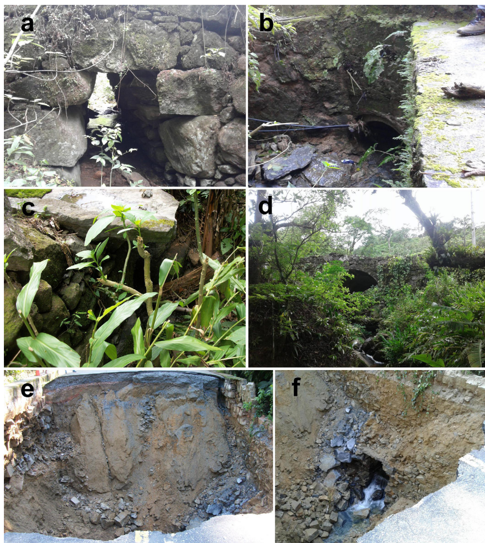
Figura 7 – Diferentes padrões de bueiros na Estrada de Mangaratiba (a, b, c); ponte em arco nas proximidades de Pouso Triste (d); bueiro rompido por explosão do pavimento em 2018 (e); detalhe da estrutura em pedra seca do bueiro rompido (f). Fotos: Soraya Almeida, 2018.
