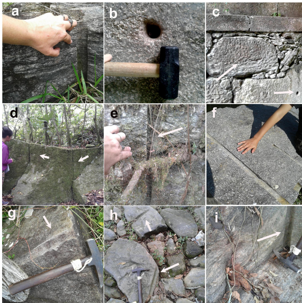
Figura 9 – Marcas de extração. Estrada de Mangaratiba: gnaiss (a), granito (b); picotes e perfuração em pedras secas (c); jazida na subseção 1 (d); cantaria da Ponte Bela (f). Estrada do Atalho: rocha da planície (g); pavimento (h); segmento da serra (i), Foto: Soraya Almeida, 2018.
