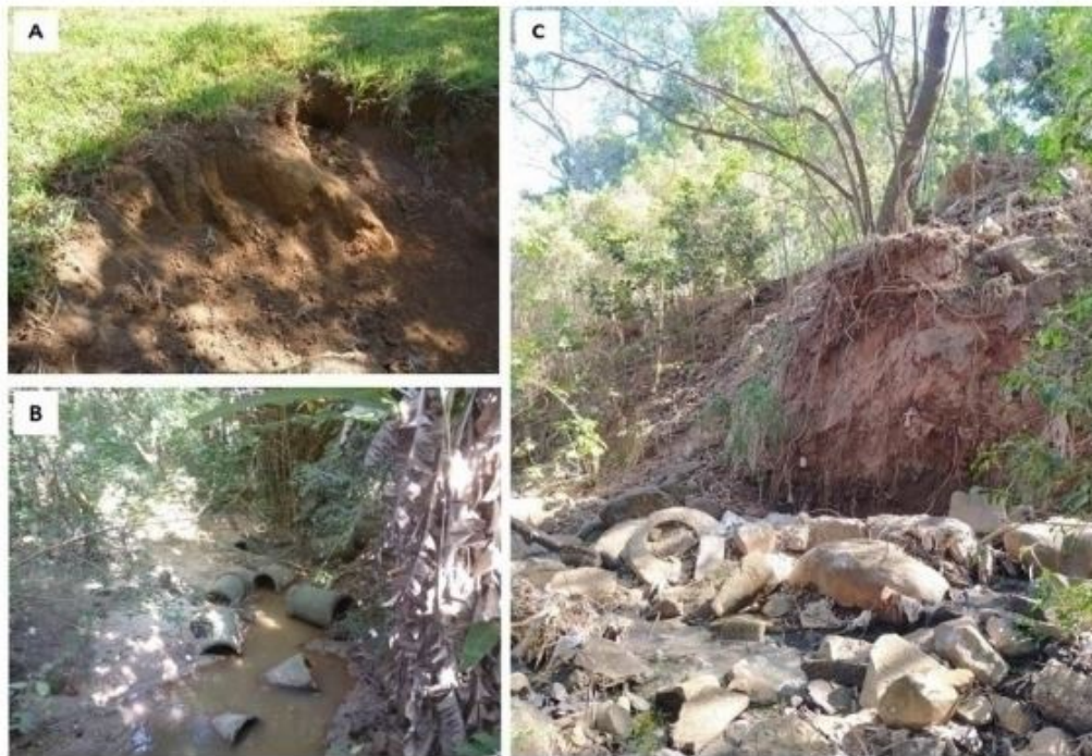
Figura 5 - [A] Erosão de margem ocasionada pelo escoamento superficial drenado para o interior da área de preservação permanente do Córrego Buritizinho, Uberlândia - MG. [B] Leito assoreado do Córrego Perpétua, Uberlândia-MG. [C] Erosão de margem no Córrego Buritizinho, na imagem é possível identificar que o processo erosivo já começa a comprometer a estabilidade da vegetação existente no local.
