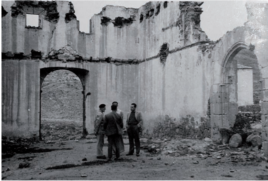
Estado ruinoso de la iglesia de san Francisco. Foto: Archivo Miguel Tarquis. Universidad de La Laguna.
