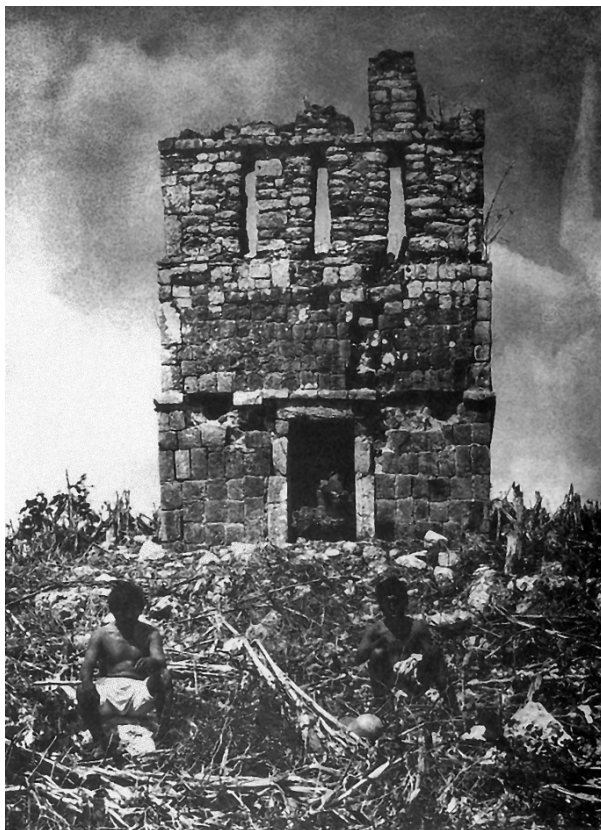
Figura 16. Edificio principal de Chunyaxnic, Campeche (Según Maler, 1997).
