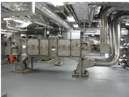
Figura 2. Filtro de aire HEPA de 3 etapas usado en el sistema de extracción de aire de un laboratorio de alta contaminación.
