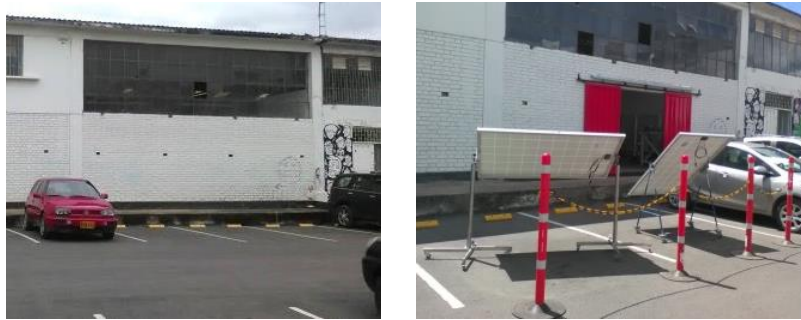
Figura 4. Adecuación de un portón para acceso de equipo (antes y después)
