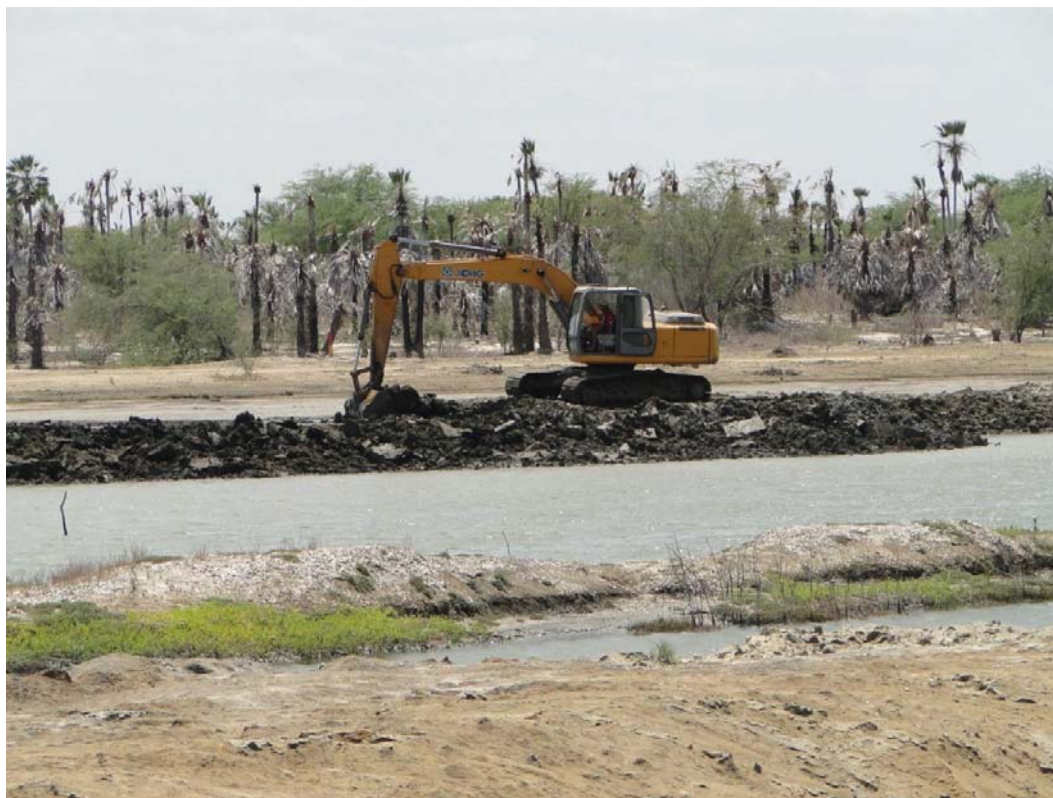
Figura 1 - Máquina realizando a dragagem do leito do rio das conchas, Porto do Mangue, Rio Grande do Norte.
