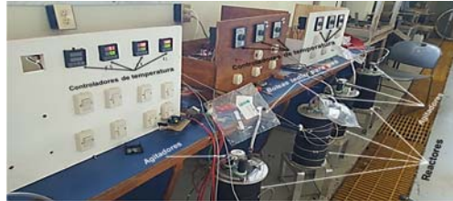
Fig. 2. Cajas de control con controladores digitales y analógicos.
