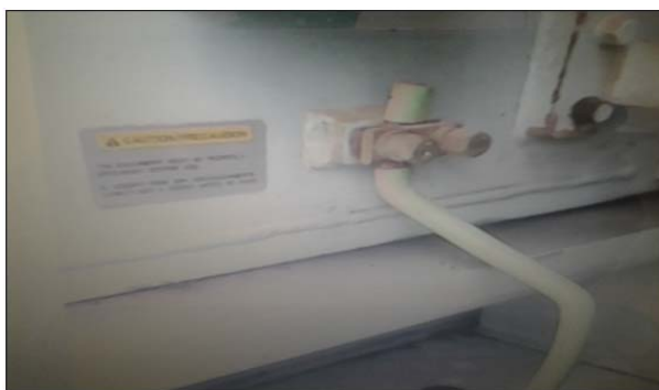
Fig. 3. Conexão de posta a terra de geradores.
