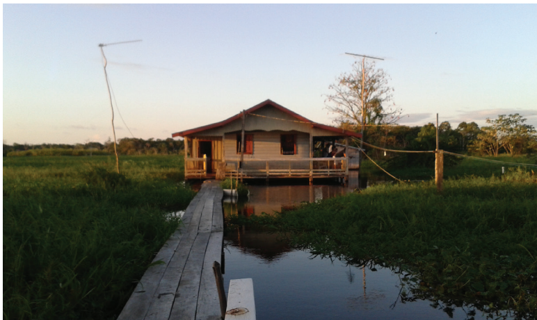
Foto 1 — Casa ribeirinha, construída para ficar fora da ação das águas do Rio Solimões/Amazonas
