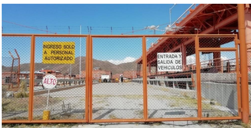
Fotografía 8. Puente Binacional controlado por la Autoridad Binacional del Lago Titicaca
