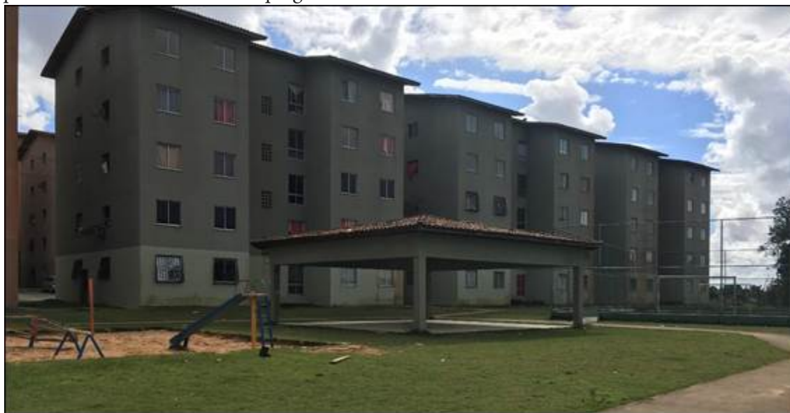
Imagem 2 – Vista de Estrutura do Condomínio São Francisco I
