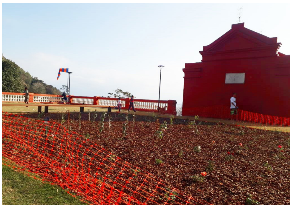
FIGURA 7 – Praça Monte Serrat, projeto de renovação do 1º Reservatório de Água de Florianópolis, Morro do Antão, Comunidade Monte Serrat, Maciço do Morro da Cruz.
