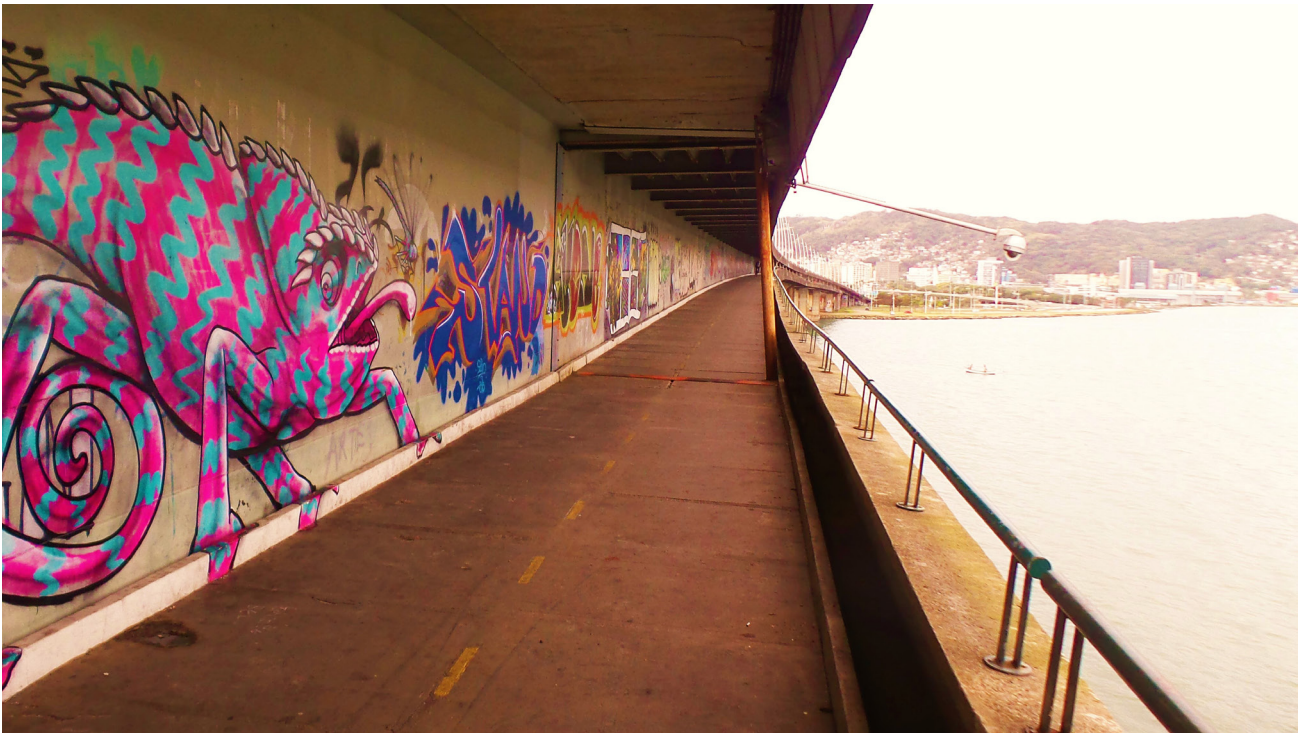
FIGURA 2 – Grafite do camaleão defronte à câmera de vigilância da passarela da Ponte Pedro Ivo Campos, Florianópolis.
