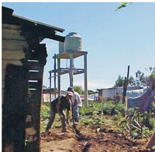
b. Tendido de cañería
