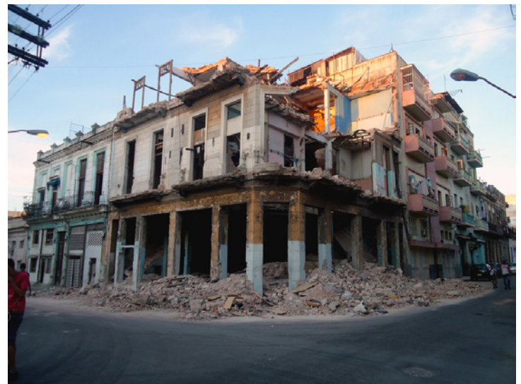
Figura 5. Edificio en demolición por derrumbe en el Barrio Cayo Hueso. Fuente: Foto autores.
