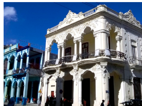
Figura 2. Edificios en la calle Reina. Centro Habana. Fuente: Foto Autores.
