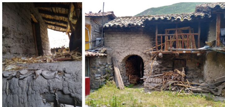
Figura 4. Pisos y cubiertas: A la izquierda, entrepiso de torta de barro y enchaclado de carrizo amarradas con soguillas de paja. A la derecha, cubierta de teja de arcilla cocida que descansa sobre tijeral de par y nudillo de rollizo de eucalipto. Fuente: Autor.
