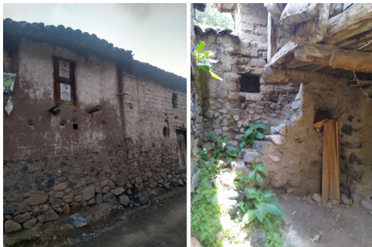
Figura 3. Muros de mampostería de piedra y barro. A la izquierda, fachada frontal donde se aprecia dichos elementos; a la derecha, integración de muro y escaleras de acceso vertical. Fuente: Autor.
