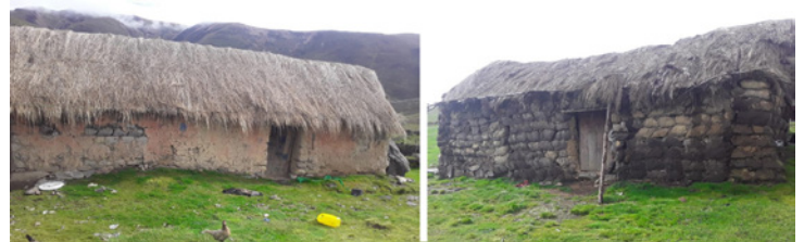
Figura 10. Recubrimientos con tierras de colores y cimentación expuesta. Fuente: Autor.
